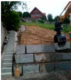
Notfalltreppe im Bau
